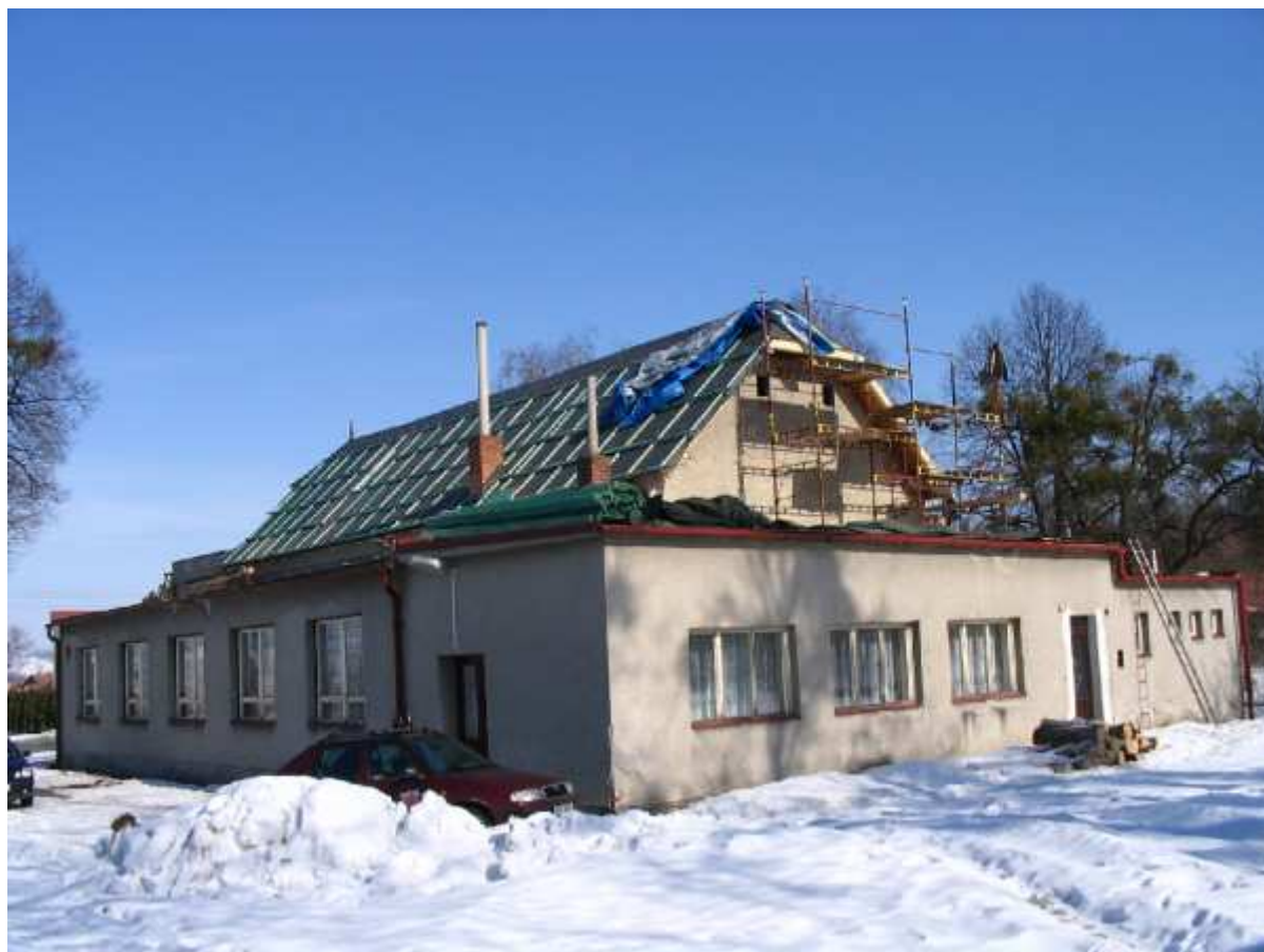
Oprava střechy sokolovny a zateplení stropů – březen 2006
