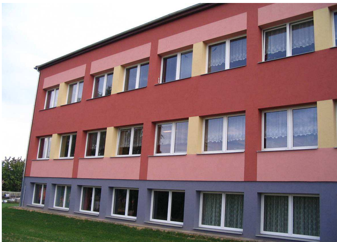
Rekonstrukce Základní a mateřské školy Skalička
