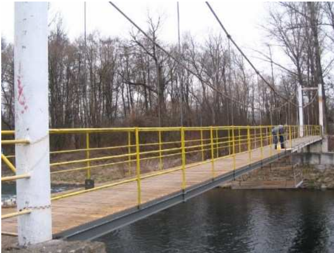
Opravená mostní lávka na Kamenci – únor 2008
