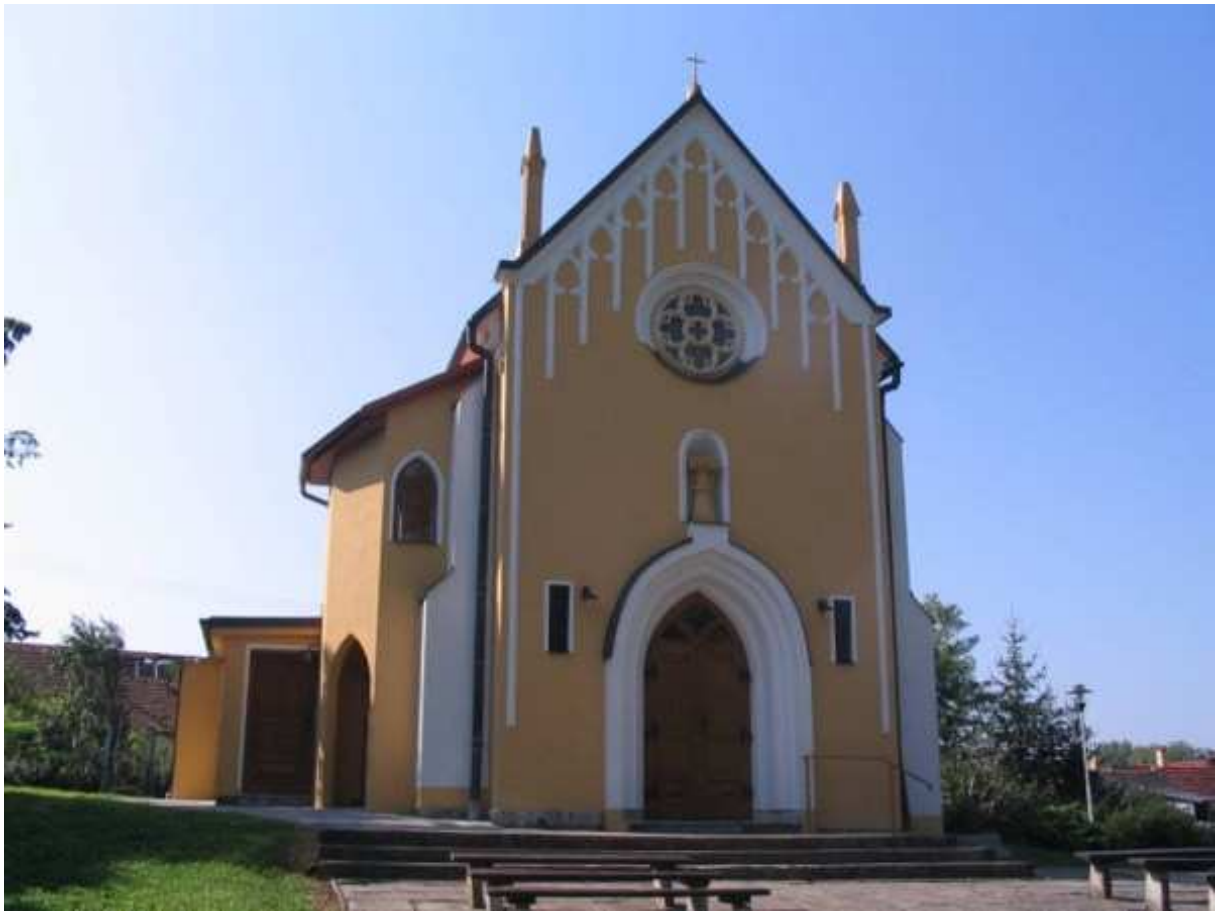
Zastřešení schodiště lesní kaple – červen 2008
